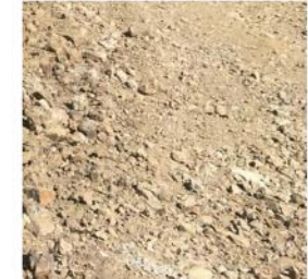
02 - Remblai terrasses arrière + Est constitué de débris concassés sur site
