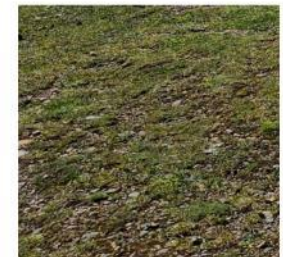
04 - Toiture terrasse revégétalisées avec espèces endémiques sélectionnés
